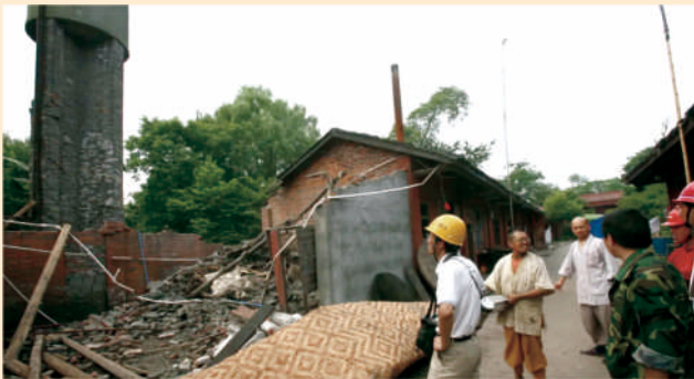
西安建筑科技大学赴四川灾区抗震救灾专家指挥危楼拆除
