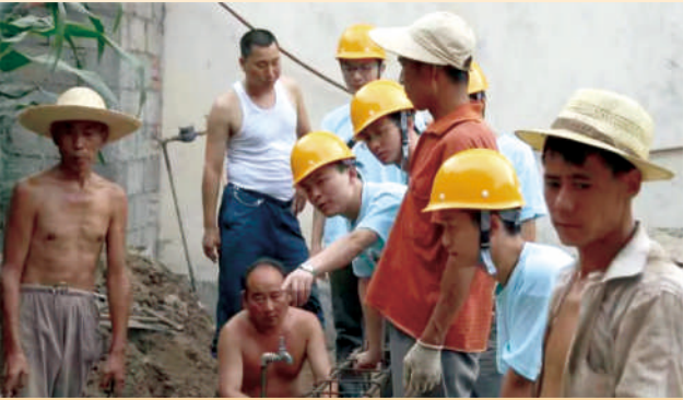
西安建筑科技大学土木工程学院大学生灾区建设规划设计施工服务团的成员在略阳县白水江镇进行施工指导
