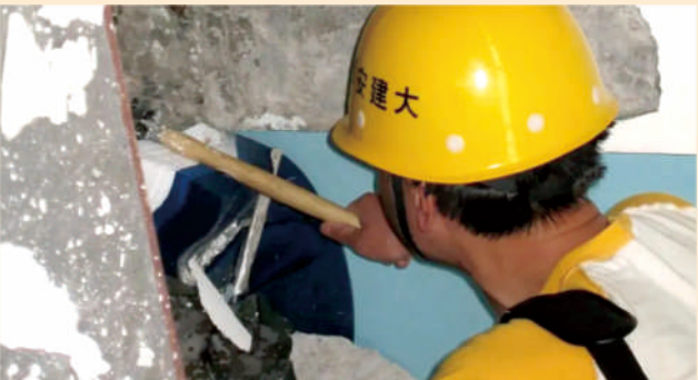
西安建筑科技大学赴四川灾区抗震救灾专家排查灾区建筑受损情况
