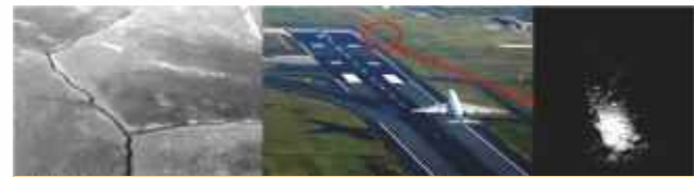
沈阳机场道面开裂及道基积水实况
