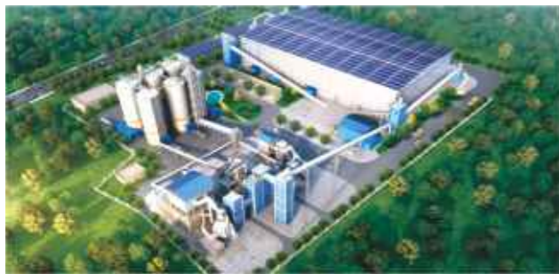
韩城钢渣综合利用项目
